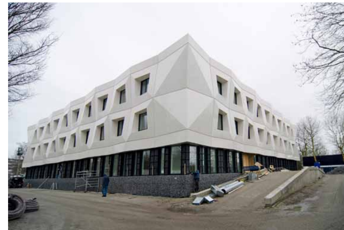
De gevelelementen moeten onderling luchtdicht zijn.
