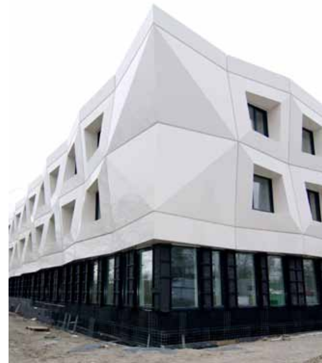
De grote elementen van composiet zijn aan de bouwkundige schil gehangen.
